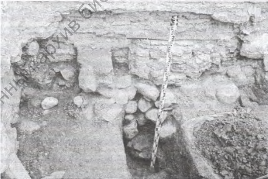
Рис. 15. Шурф 2 у северного отрезка восточного фасада. Вид с востока. Вскрытый участок восточного фасада, фрагмент разобранной лопатки с полуколонной, шурф-зондаж для изучения фундамента храма (фундамент вскрыт до подошвы). Слева – участок отмостки XII в.
