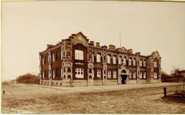
Здание Александровской ОСМ по ул. Малая Садовая в Могилеве (совр. ул. Пионерская, р-н кинотеатра «Родина», не сохранилось)
