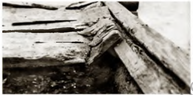
Ил. 14. Половицы – массивные дубовые плахи, которые затесанными на клин концами укладывались на полочки в стенах постройки П – XV – 6. Деталь. Раскоп 1978 г.
