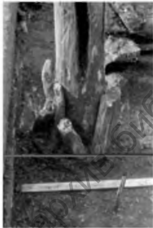
Ил. 12. Крепление столба – опоры с помощью вбитых по его окружности кольев. XIII в. Раскоп 1983 г.
