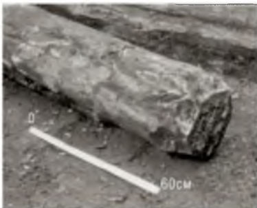
Ил. 11. Обработка торцевой части бревна – опоры, снята фаска с целью уменьшить проникновение влаги в эту опору. XIII в. Раскоп 1983 г.
