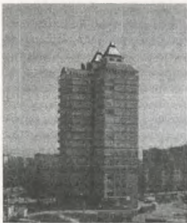
Фото 3.45. При съемке с уровня середины здание выглядит ровно
