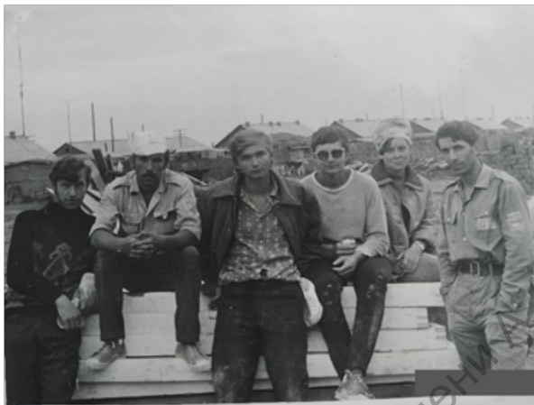
На стройке ССО Днепр-74. Чапаевский район Уральской области (1974 г.)
