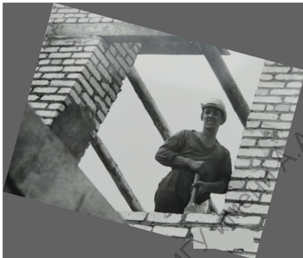
На стройке ССО Днепр-72. г. Джембейты, Уральская обл. (1972 г.)
